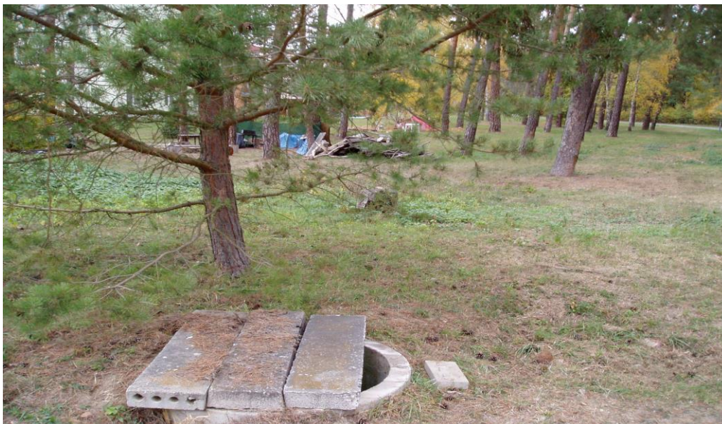
Pohled na stávající vzdušnickovou šachtu A 60 st. 0,2420 km, která bude zbourána
