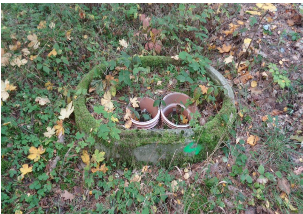
Pohled na stávající podzemní hydrant Hy – V54 st. 4,4367 km
