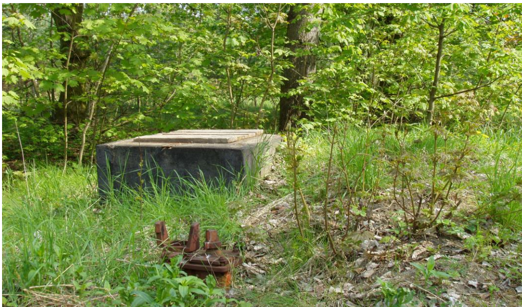
Pohled na stávající vzdušňovací šachtu A58 st. 0,9151km, která bude zbourána
