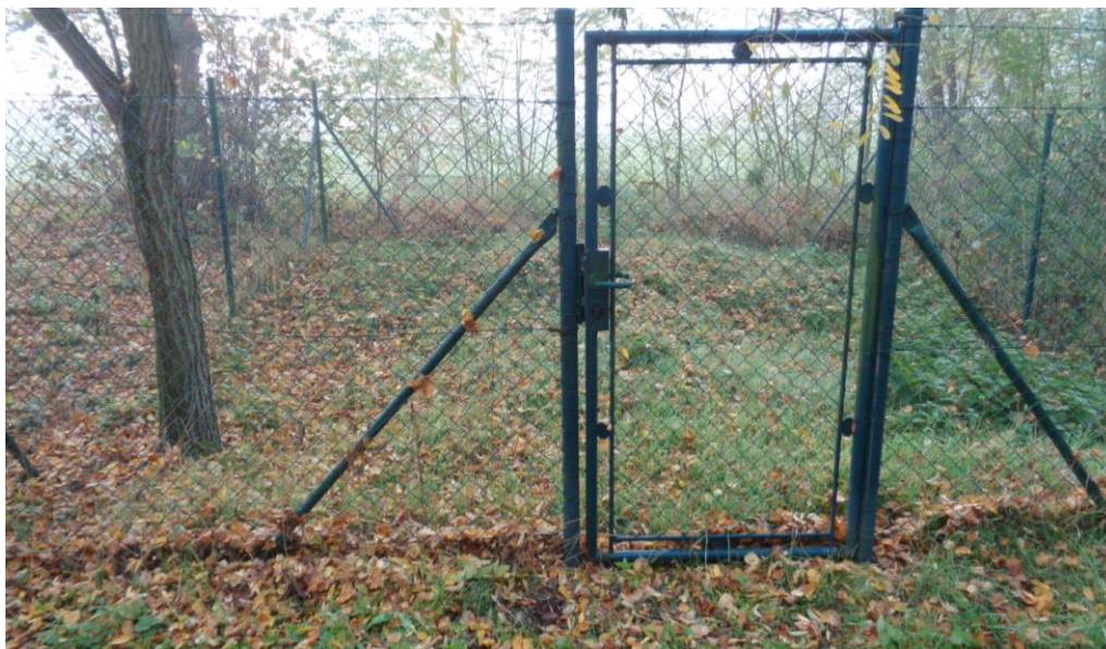
Pohled na stávající oplocení u hydrantu H1 st. 0,0000 km
