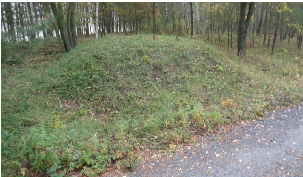
Pohled na armaturní šachtu A725 – V52 st. 4,2450 km, která bude zbourána
