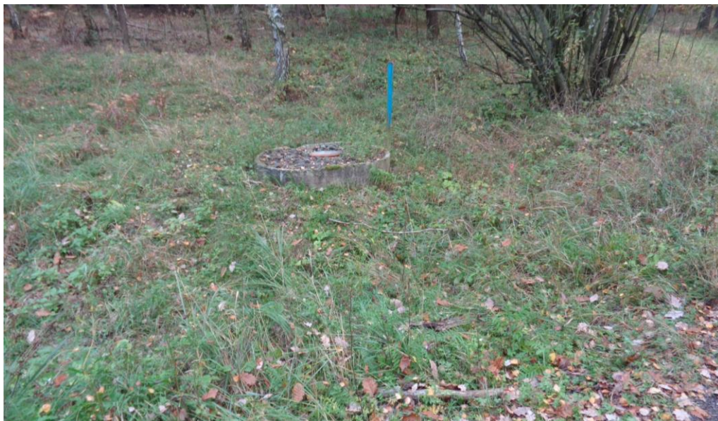
Pohled na stávající podzemní hydrant Hx - V29 st. 2,2863 km
