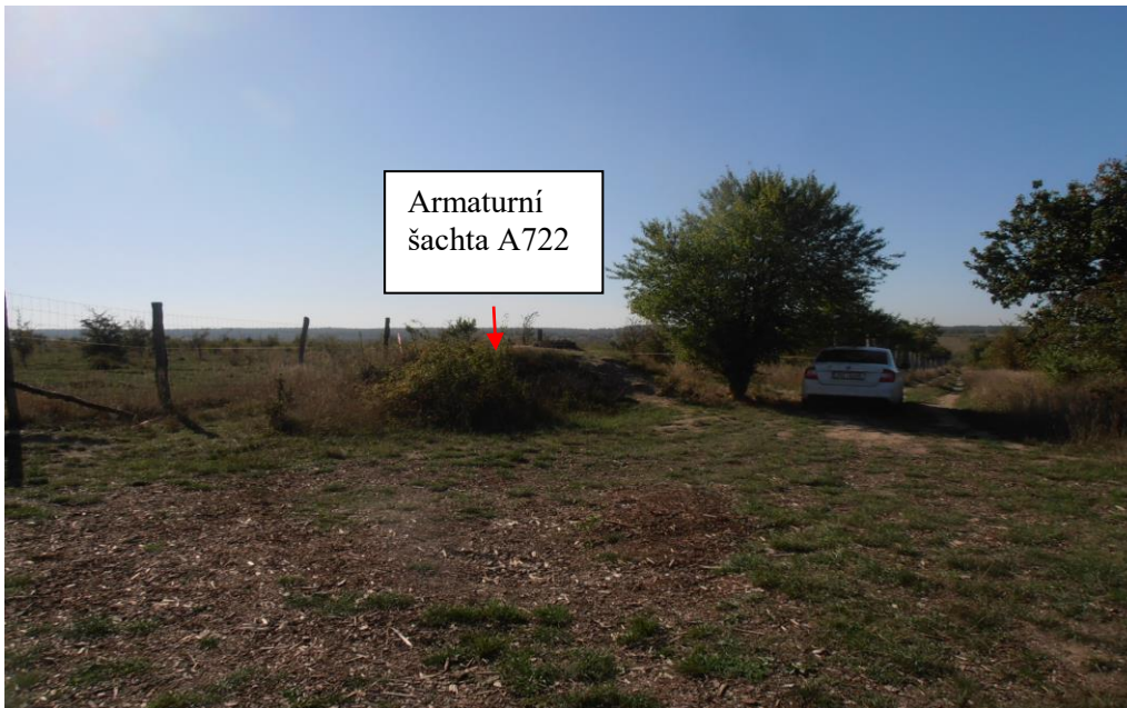
Pohled na armaturní šachtu A722 – V72 st. 5,6889 km, která bude zbourána
