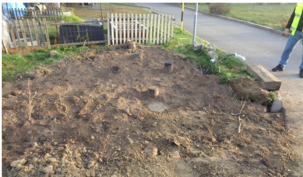
Pohled na stávající stav armaturního uzlu
